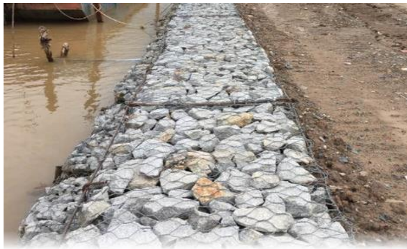
Hình 2: Kè bảo vệ bờ sông bằng rọ đá
